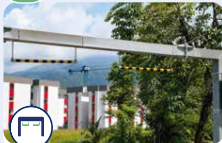
Pórtico de gálibo con semáforo y tubos colgantes .
