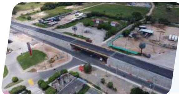
El diseño de estas intersecciones combina innovación y funcionalidad. La Virgen organiza el tráfico con ramales que conectan las rutas hacia Villavicencio y Sogamoso con el casco urbano de Aguazul y Yopal. Por su parte, El Coleo, con un paso elevado tipo trompeta, asegura movimientos fluidos entre los municipios, minimizando tiempos y mejorando la seguridad vial.
