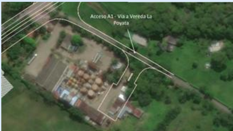
Acceso A1 (K07+000), vereda La Poyata.
