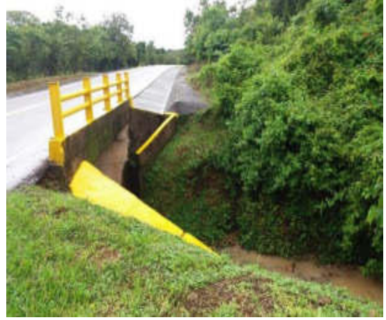
Vista final del predio
