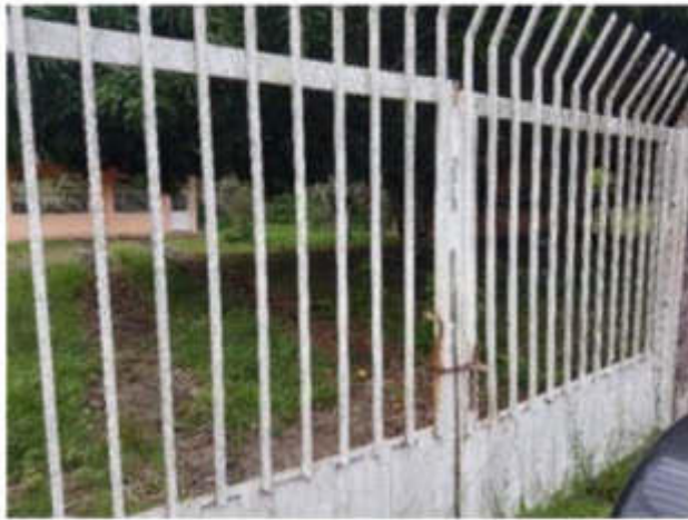
Po2: Portón de entrada vehicular metálico.
