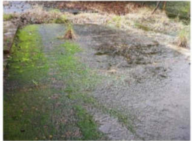
Zd1: Zona dura en concreto
