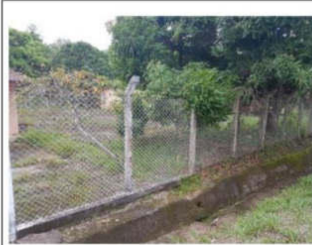
Cr: Cerramiento con viga de arrastre, con malla eslabonada
