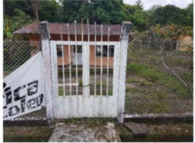
Po1: Portón de entrada peatonal metálico.
