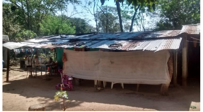
C1- Construcción Mj1|
