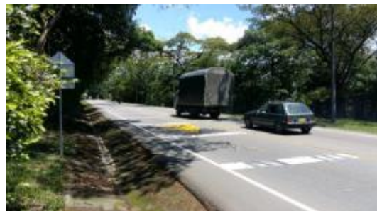
Vía margen izquierda
