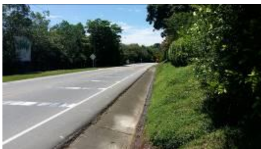
Vía margen derecha
