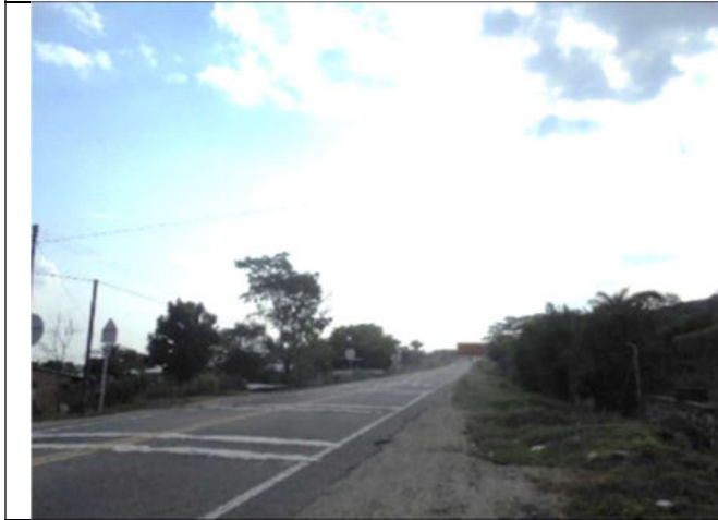
Vista vía frente al predio
