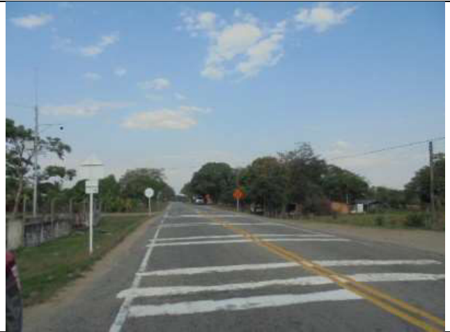
Vista vía frente al predio
