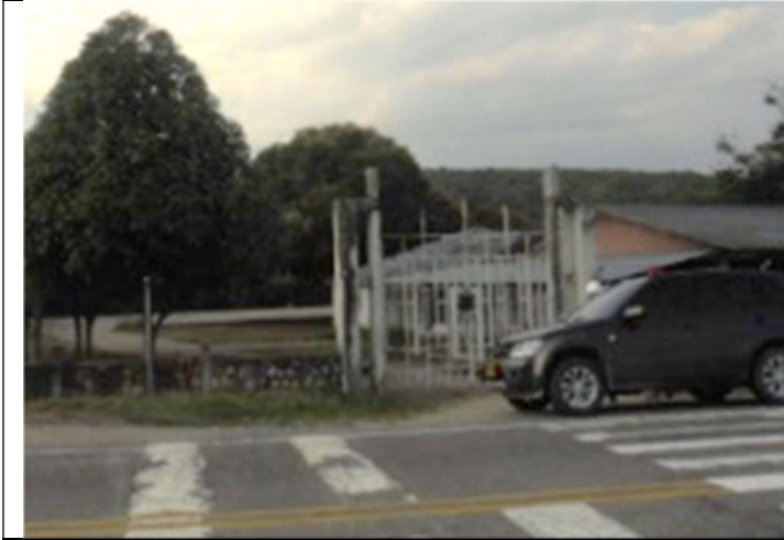
Po: Portón – Vista general
