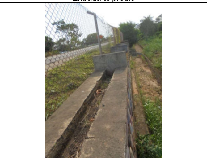
Mu: Muro – Vista de detalle
