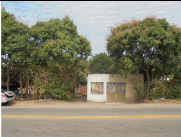
Vista parcial fachada del predio
