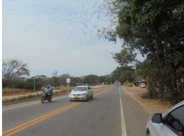
Vista parcial vía Aguazul
