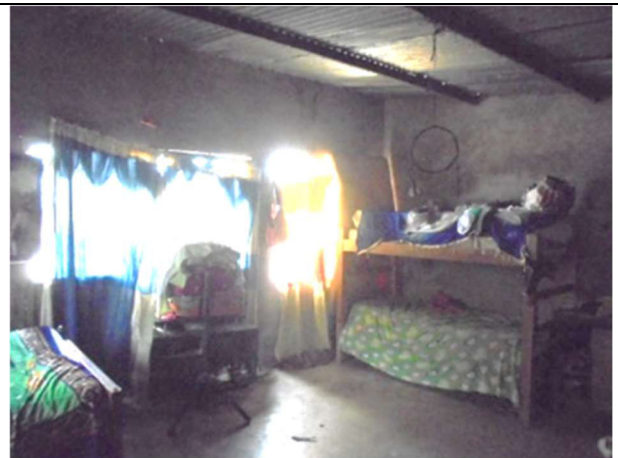
C1: Construcción – Vista interna
