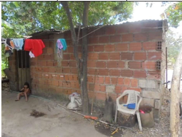
C1: Construcción – Vista interna
