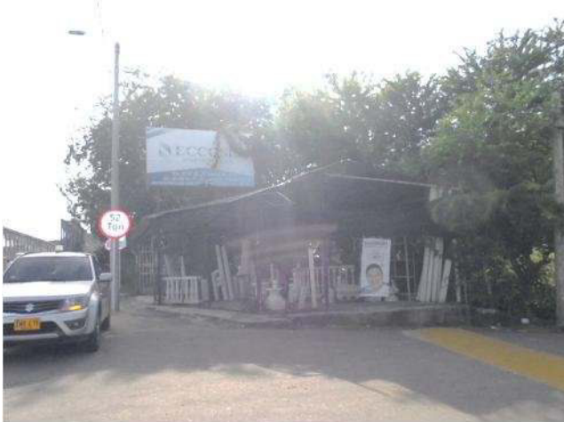
Vista parcial fachada del predio
