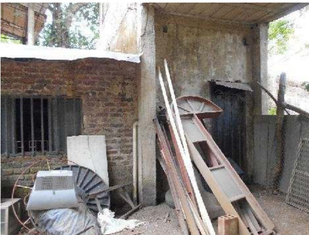
C1- Construcción 1° piso
