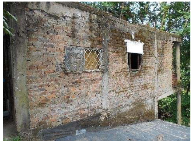
C1- Construcción 2° piso
