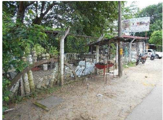
Vista parcial fachada del predio
