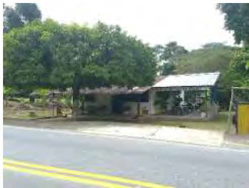
FACHADA PPAL FTE: 51.85 m PANORAMICA SOBRE VIA NACIONAL RUTA 6511
