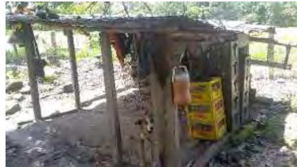
ENRAMADA En.- PISOS EN CCTO., ESTRUCTURA EN MADERA REPISA (4cm X8 cm)
