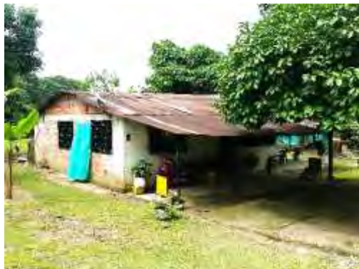
CONSTRUCCION C1.- MUROS BLOQUE FLEXA CUBIERTA TEJA DE ZINC
