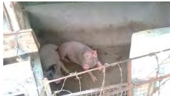
MARRANERA Ma.- PISOS CCTO. MUROS PAÑETE
