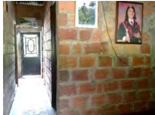
AREA SOCIAL PASILLO ALCOBAS MUROS BLOQUE A LA VISTA
