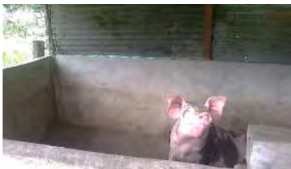
MARRANERA Ma.- PISOS EN CCTO MUROS EN PAÑETE – CERRAMIENTO Y CUBIERTA EN ZINC
