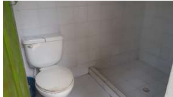
BAÑO MUROS ENCHAPADOS CERAMICA 20X20
