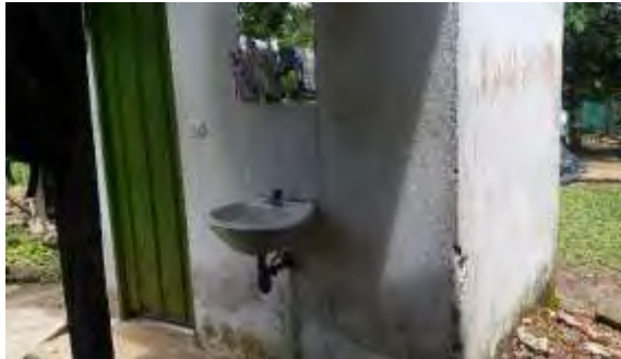
BAÑO Ba.- MUROS PAÑETE Y VINILO – LAVAMANOS –PUERTA METALICA
