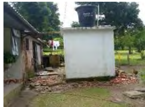
MODULO DE BAÑO Ba.- MUROS PAÑETE Y VINILO CUBIERTA EN CANALETA ETERNIT
