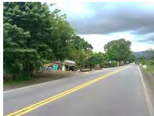
ABCS FINAL K 39 + 508,74(d) PANORAMICA SOBRE VIA NACIONAL RUTA 6511
