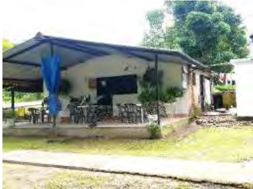
COBERTIZO Co.- ESTRUCTURA METALICA COLUMNAS CUBIERTA TERMOACUSTIC
