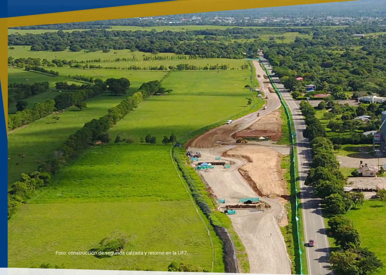
Foto: construcción de segunda calzada y retorno en la UF7.
