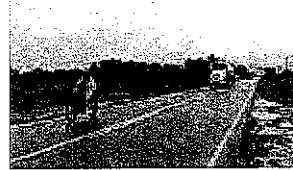
PANORAMICA FRENTE SOBRE LA VIA
