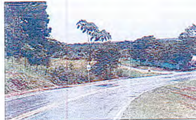
PANORAMICA FRENTE SOBRE LA VIA
