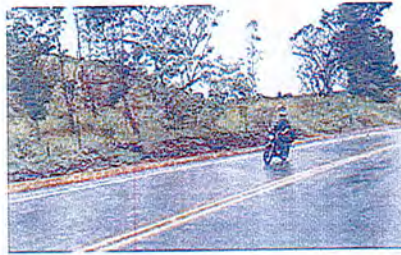
PANORAMICA FRENTE SOBRE LA VIA
